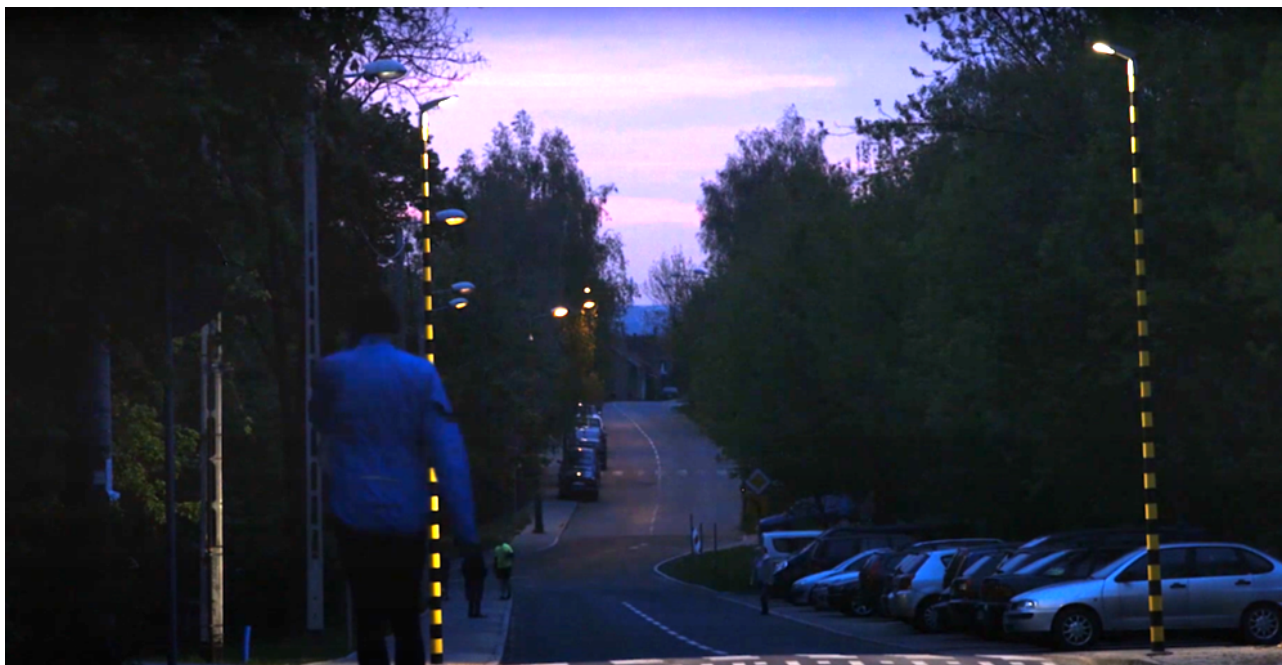
Doświetlenie wertykalne przejść dla pieszych – oświetlające sylwetkę pieszego a nie zebra.
